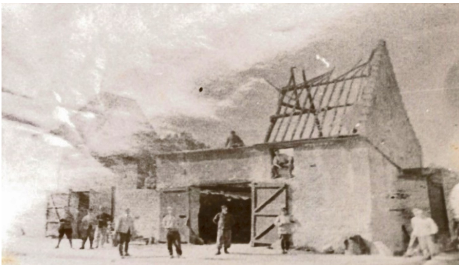
La ferme Pamart après l'incendie
